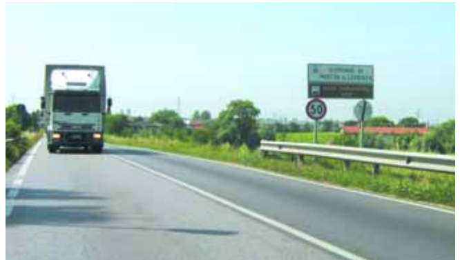
L'inizio di via Magnadola: presto i lavori per l'allargamento
